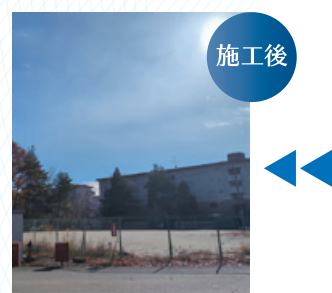
蓬萊高架水槽撤去工事(蓬萊町4丁目地内)
