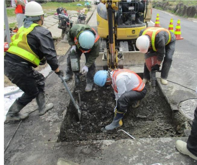
修繕完了状況(給水管の切り離し作業)
