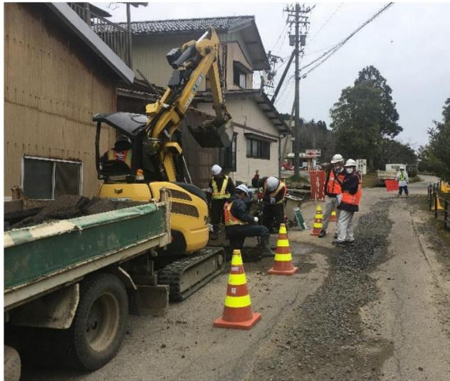
修繕工事(人力での路盤掘削作業)
