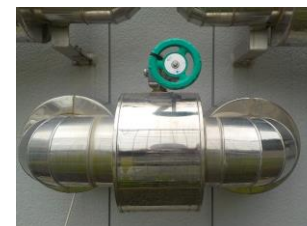
▲連通管に給水栓を設置
