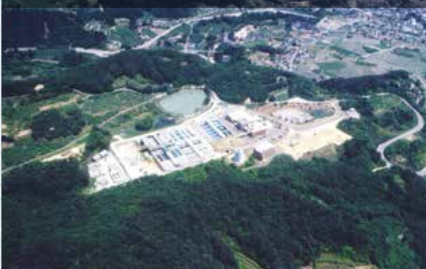
すりかみ浄水場全景
